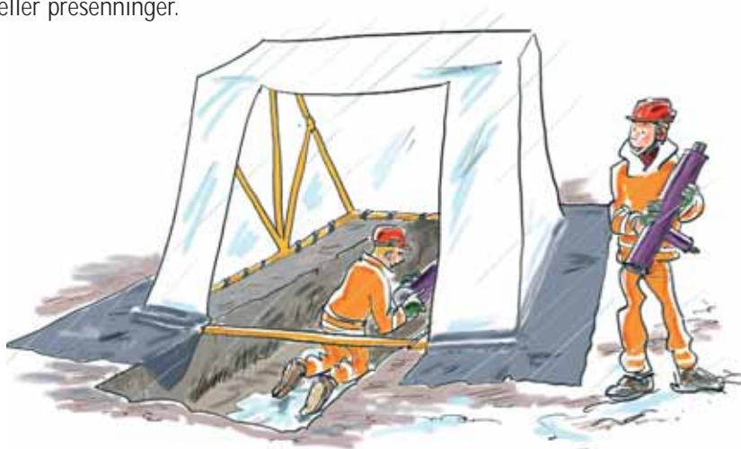
Traditionelle teltløsninger til kabel- og ledningsarbejde
