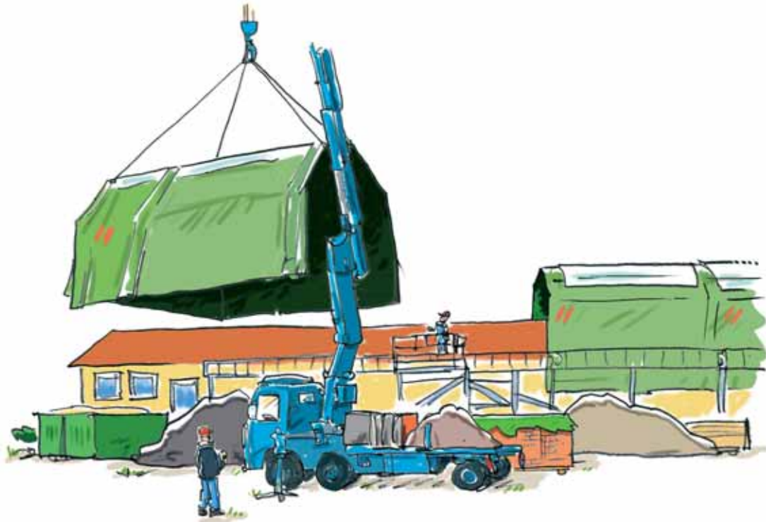
Teltmoduler håndteret med lastbilmonteret kran
