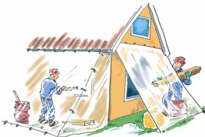
Afdækning ved facadearbejder på et et-planshus
